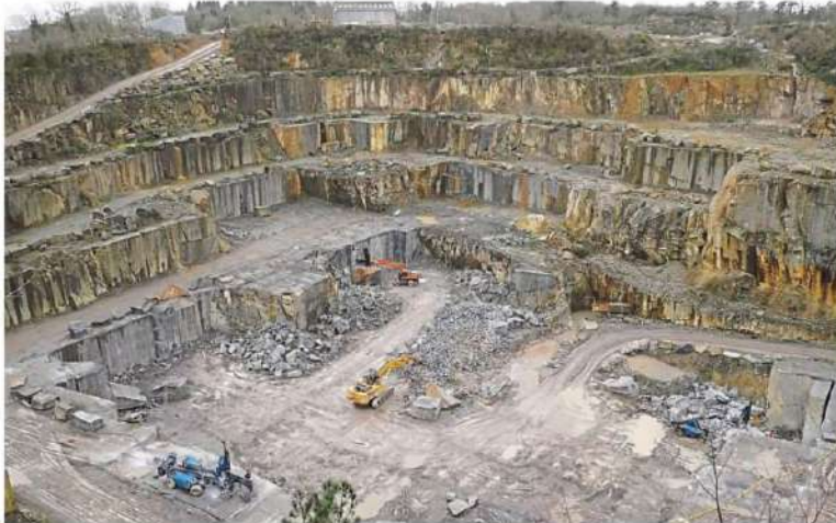
La carrière de Lanhélin fait 45 mètres de profondeur.
